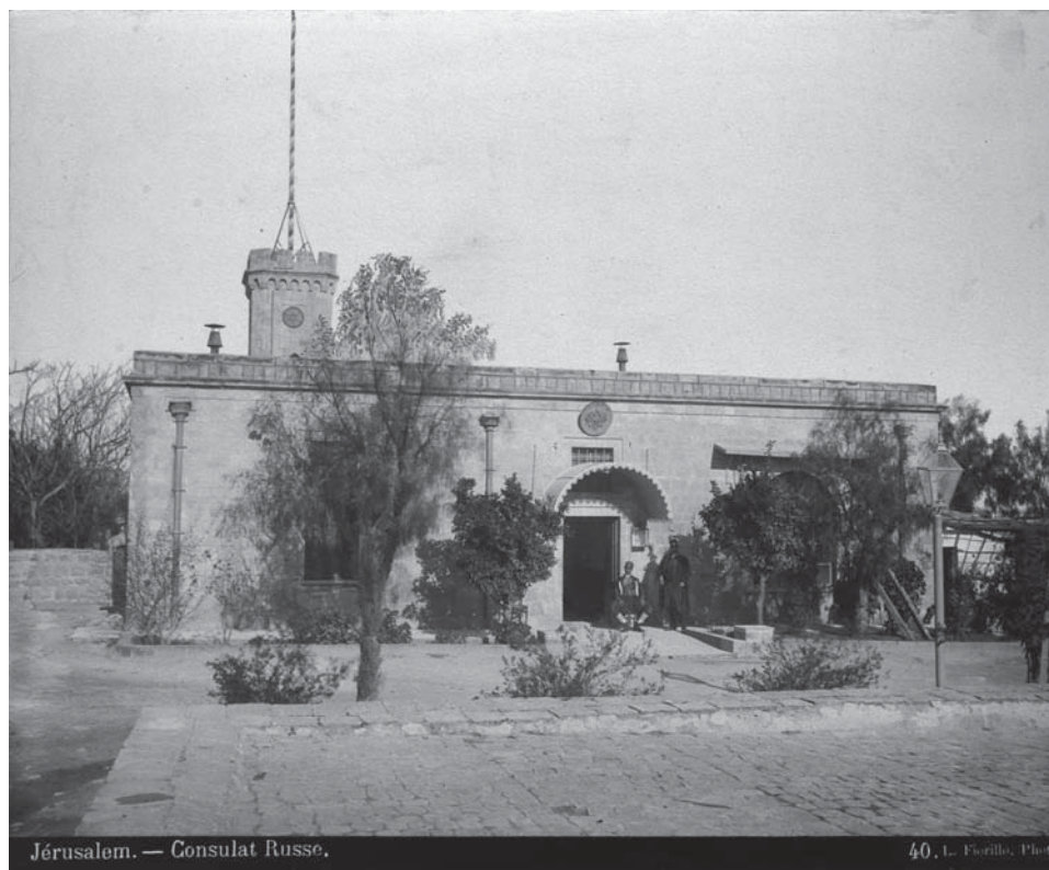
Южный флигель здания русского консульства. Фото Л. Фиорильо. 1880-е гг.
