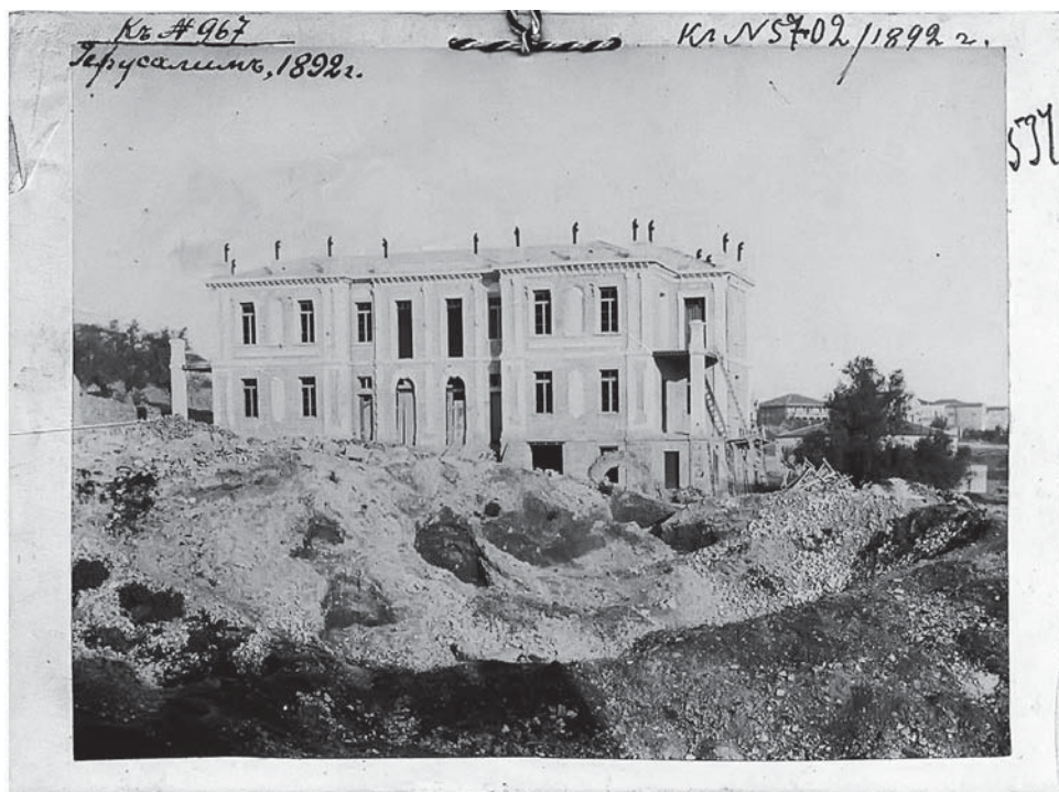
Вид строящегося консульского дома. Фото 1892 г. АВПРИ. СПб Главархив IV-18. Оп. 136. Д. 1. 1859–1895 гг. Л. 537.
